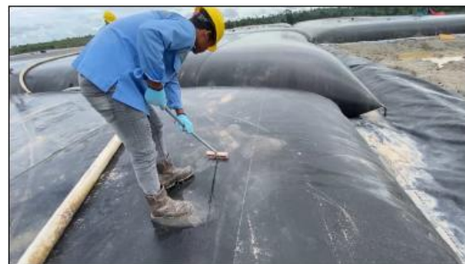
Gambar 8. Proses pemeliharaan geotube
